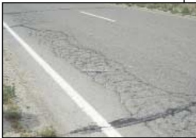
Рисунок 14 – Усталостная деструкция асфальтобетонного покрытия автомобильной дороги по Руководству [13]: высокий уровень
