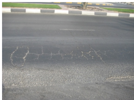
Рисунок 8 – Усталостная деструкция асфальтобетонного покрытия: сетка трещин типа «крокодиловая кожа» (г. Шарджа, Объединенные Арабские эмираты, август, 2010 год)
