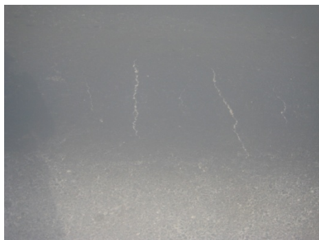
Рисунок 5 – Усталостная деструкция асфальтобетонного покрытия: поперечные усталостные трещины (г. Шарджа, Объединенные Арабские эмираты, август, 2010 год)
