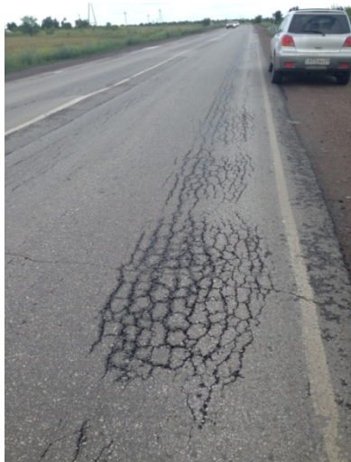
Рисунок 2 – Усталостная деструкция асфальтобетонного покрытия автомобильной дороги «Караганды-Шахтинск» (июль, 2016 год)
